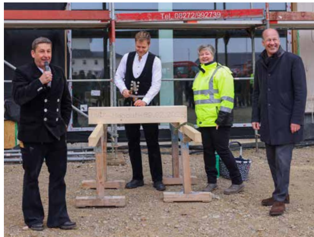
Grund zum Feiern gab es Anfang der Woche auf der Baustelle des neuen Umweltkompetenzzentrums in Langerringen, als Landrat Martin Sailer (rechts) und Daniela Bravi, Werkleiterin des Abfallwirtschaftsbetriebs (Zweite von rechts) im kleinen Rahmen zu einem Richtfest einluden. Bildquelle: Lina Prinzensing
