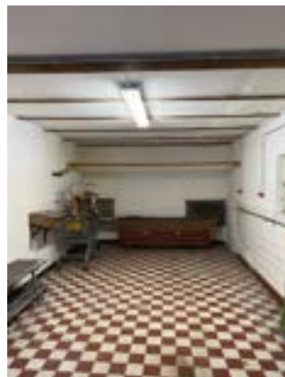
Innenansicht vor der Erneuerung des Raums
